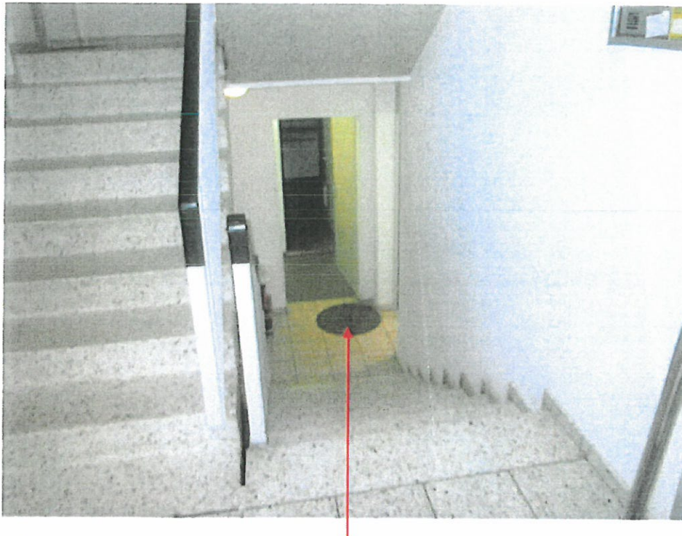
Sicht vom Hauseingang her in den Keller; Abwasserschacht
