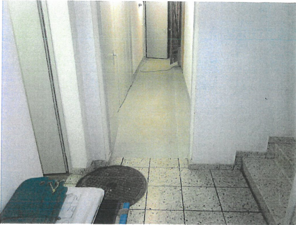
Sicht vom Treppenhaus Richtung Keller
